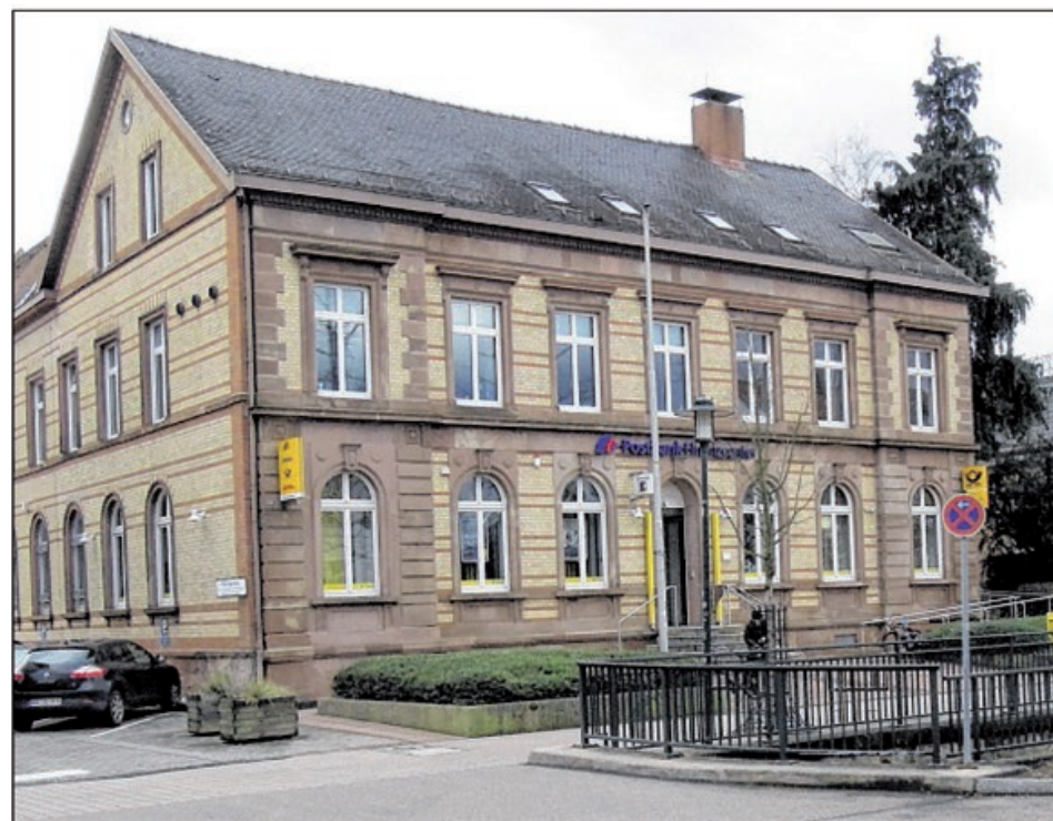
EIN TYPISCHES WERK des späten 19. Jahrhunderts ist das Postamt in der Eisenbahnstraße in Bühl. Foto: Coenen
