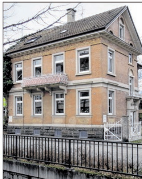
GUSTAV WERTHEIMER errichtete die aufwendigere der beiden Villen.
