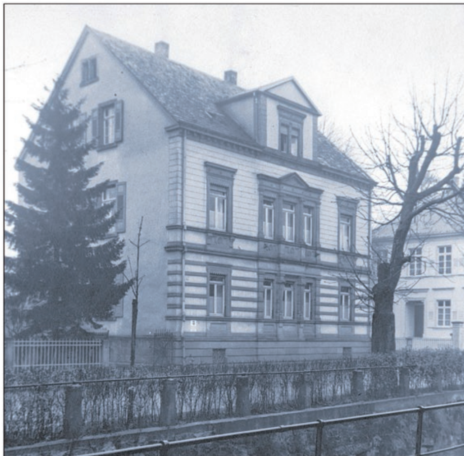
VERLORENE PRACHT: Die Werksteinbänder im Erdgeschoss und die Rustika im Obergeschoss der Villa Mittenmaier sind verschwunden. Foto: Stadtgeschichtliches Institut
